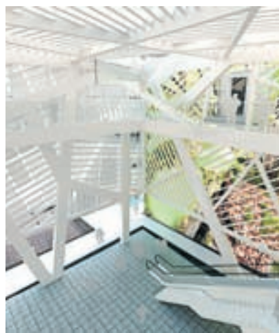
Den svenska paviljongen vid världsutställningen i Shanghai är en avancerad träkonstruktion.
